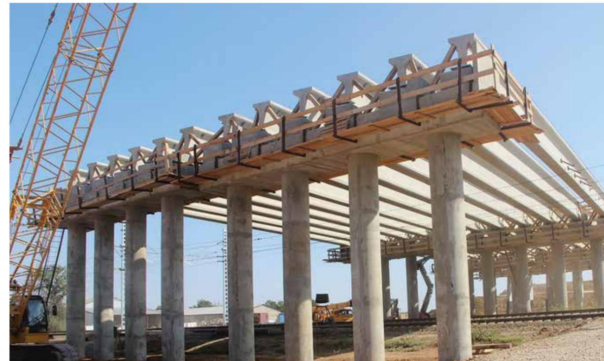
Как и балки типового проекта 3.503.1-81, новые балки можно изготавливать в условиях строительной площадки. Относительная простота создания опалубки и мобильные бетонные заводы упрощают строительство дорожных магистралей. Кроме того, за один рейс транспорт способен перевезти две-три балки вместо одной, что влияет на экономичность и эффективность транспортировки.
